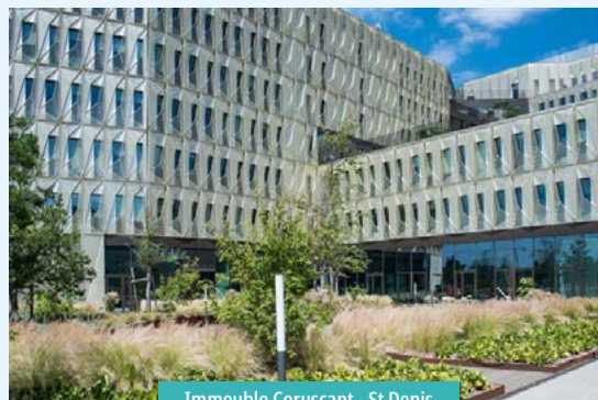
Immeuble Coruscant - St Denis
