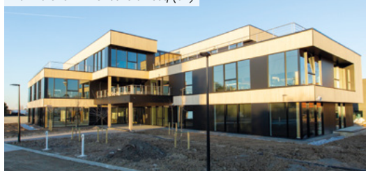
La Pilaterie – Villeneuve-d'Ascq (59)
