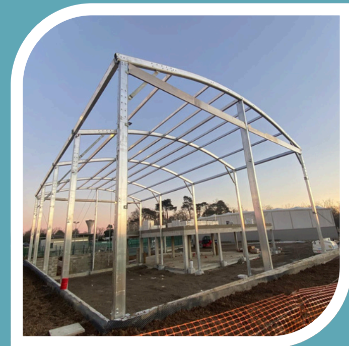
Construction du centre de padel à Camblanes-et-Meynac (33)
